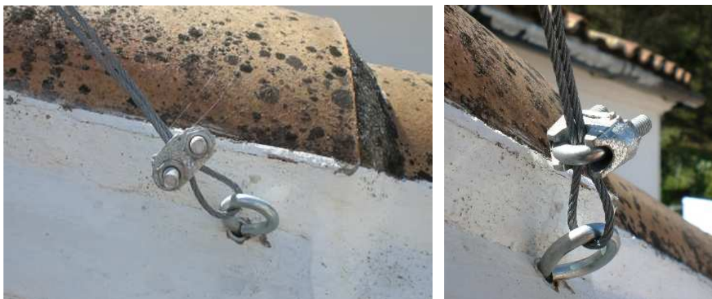
Sujeta cables ó "perrillos"
