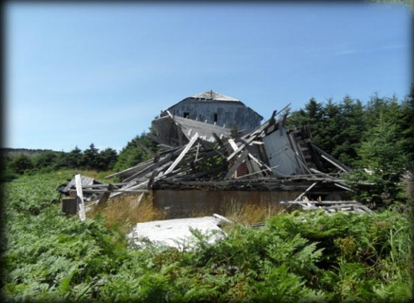
Casa anexa derruida
